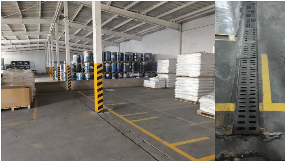
原料库内化学品分区和液体区防泄漏收集渠
